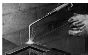
Figura 18. Soldadura con latón
