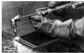
Figura 19. Corte autógeno de acero
