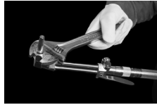
Figura 7. Instalación de la boquilla para cortar
